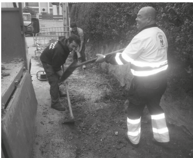
La cuadrilla municipal reparó el saneamiento de La Cambera.
