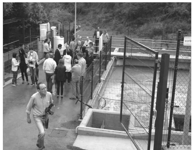
Vista de las nuevas instalaciones.
