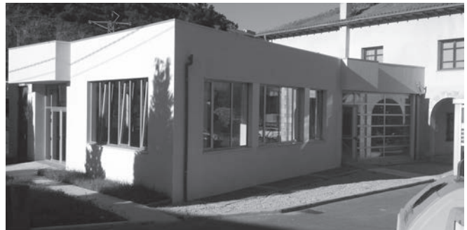
Vista de la ampliación.
