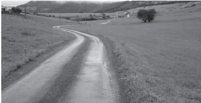
Camino reparado en Serdio.
