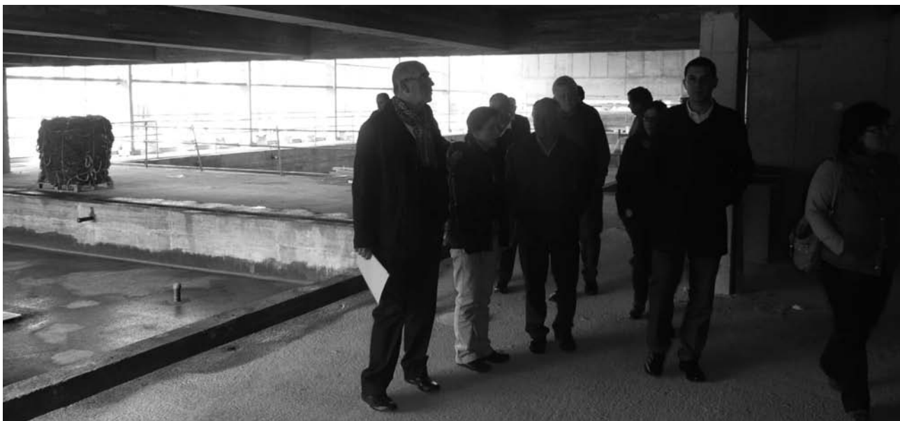
Roberto Escobedo junto al presidente del Consorcio de Infraestructuras Deportivas de Cantabria, Jose Ángel Hierro supervisaron con los técnicos y miembros del equipo de gobierno la evolución de las obras de la piscina.
